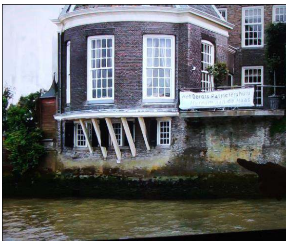
Foto 6 met rechts in de stadsmuur de trap van de eerste Maaskamer nog te zien
