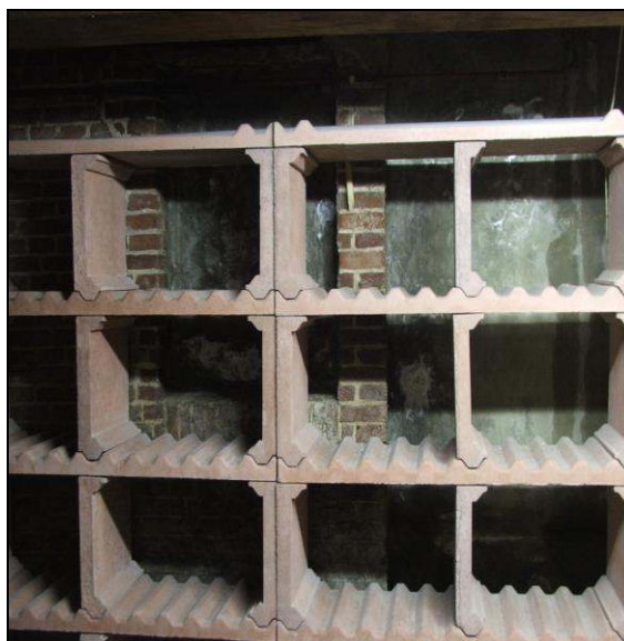
Ruimte -1.4 achtergevel met dichtgezette deur en raam
