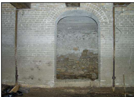
Wand D in ruimte -1.2 schoonmetselwerk op oude fundering met balken midden op de muuropening
