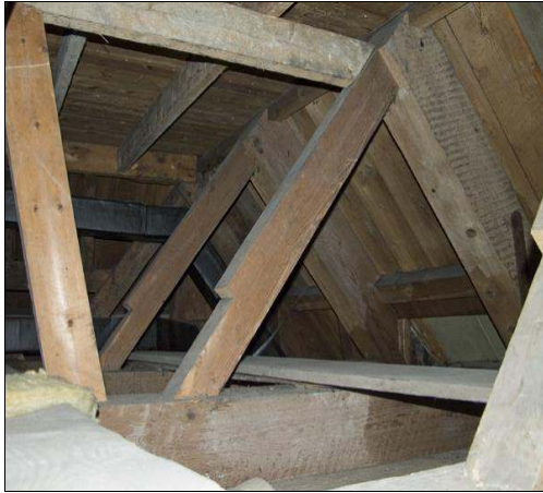
Kap boven de Maaskamer waarbij de oude spantvorm goed te zien is. Rechter schuinstandbeen is veel zwaarder
