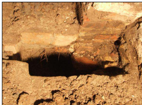
Doorgang -1.9 naar -1.4 onder vloer doorlopende naad
