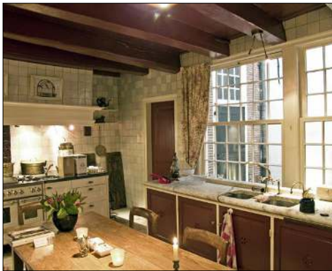
Huidige keuken (ruimte 0.8) met zware gedisselde balken
